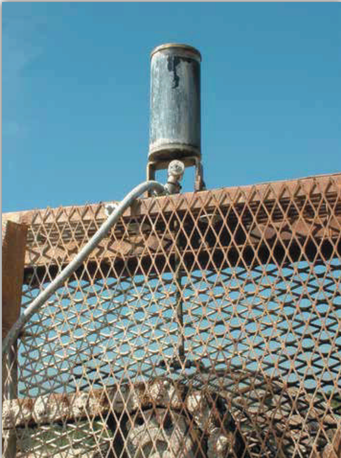
La aceitera de cadena lubricando una cadena en una pantalla de colección de basura
