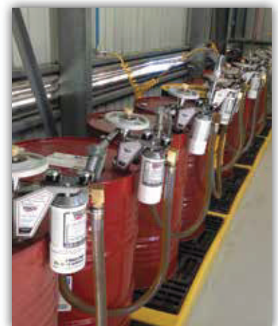
Bomba con motor eléctrico instalado sobre el sistema de filtración por bomba de tambor
