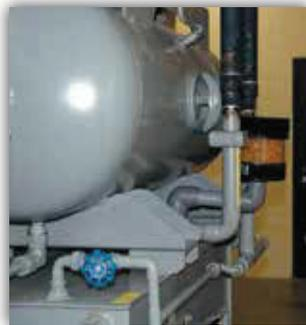
Respirador Watchdog® instalado en un tanque hidráulico.
