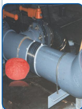
**DESCRIPCIÓN:** Es una masilla húmeda incombustible, de baja densidad no asbestos que aplicada sobre las superficies calientes conforma un recubrimiento aislante de baja conductividad térmica, excelente resistencia térmica y excelente apariencia física (se puede pulir y pintar), ideal para aislar superficies difíciles.
